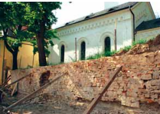
Dvůr bývalého pivovaru před rekonstrukcí...
